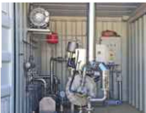
La chaudière est installée dans le conteneur. Son pilotage peut être automatique ou manuel.
